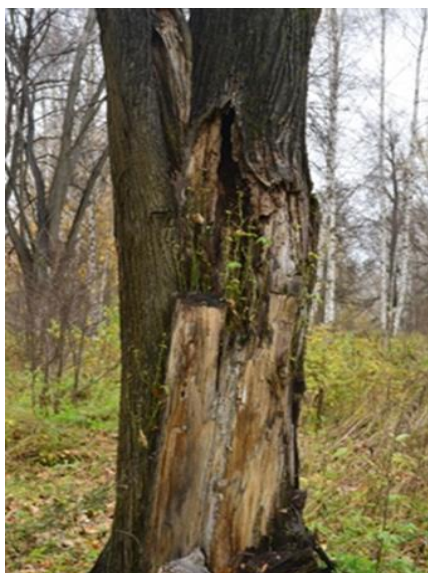
Фото 30. Механические повреждения дуба
